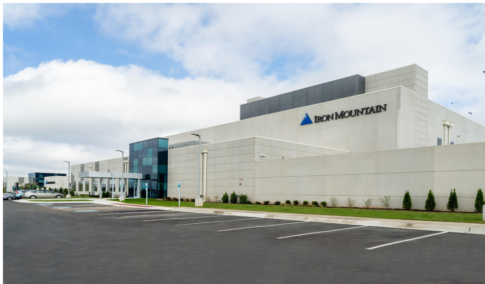
New VA-2 Data Center in Manassas, VA
